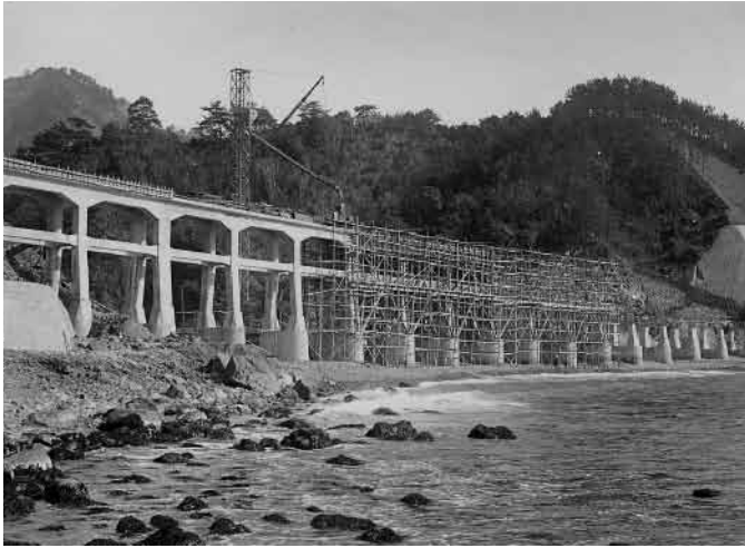
建設中の惣郷川橋梁
