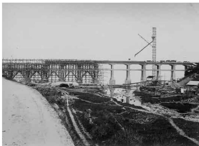
建設中の惣郷川橋梁
