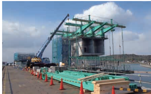
●小野田湾岸線新有帆川大橋(仮称)上部工片持架設
