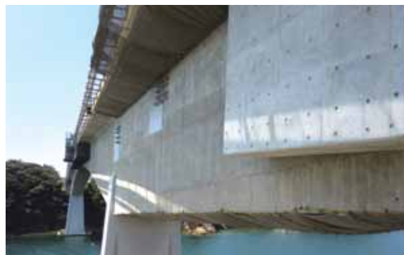
●主要県道光上関線(上関大橋)橋梁補修工事
