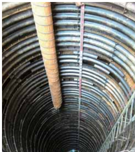
深礎杭床掘確認
