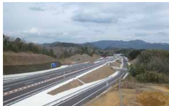
●一般国道490号 小郡萩道路
