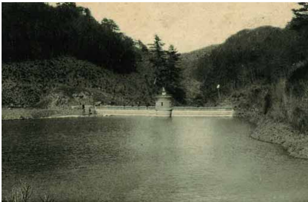
開業当時の小郡上水道貯水池
