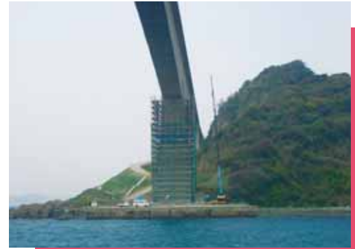
●彦島大橋 橋梁補修工事
